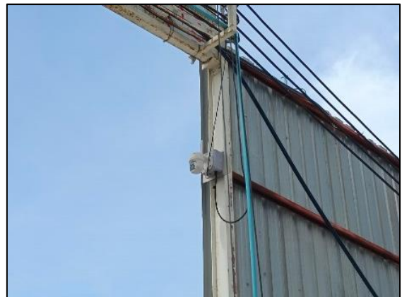
รูปที่ 2-15 กล้องวงจรปิด (CCTV)
