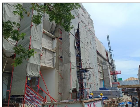
รูปที่ 2-34 Mesh Sheet
