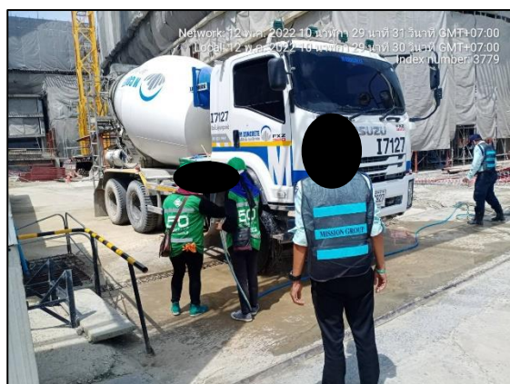
รูปที่ 2-5 กิจกรรมล้างล้อรถบรรทุกก่อนออกนอกบริเวณโครงการ
