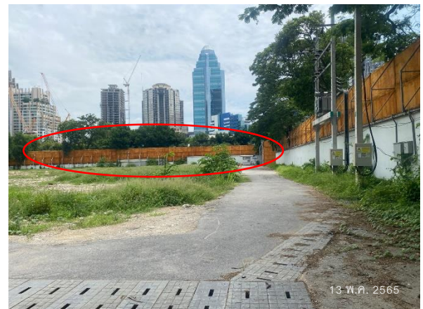
รูปที่ 2.2 รั้ว Metal Sheet ความสูง 6 เมตร
