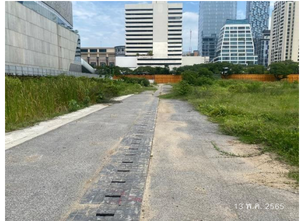
รูปที่ 2.58 รางระบายน้ำในพื้นที่โครงการ
