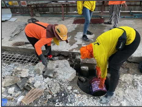
ภาพที่ 40 ขุดลอกท่อระบายน้ำ
