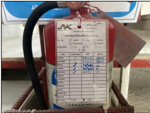
ภาพที่ 22 ตรวจสอบถังดับเพลิง
