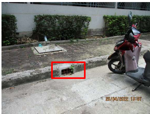
รูปที่ 4 ท่อระบายน้ำและตะแกรงดักมูลฝอย
