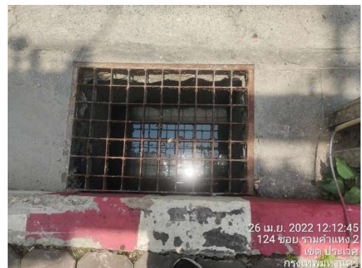
รูปที่ 4 ท่อระบายน้ำและตะแกรงดักมูลฝอย
