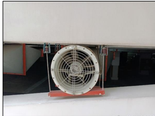
ภาพที่ 7 ระบบระบายอากาศในชั้นใต้ดิน
