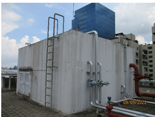
รูปที่ 13 ถังเก็บน้ำสำรองชั้นดาดฟ้า
