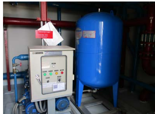
รูปที่ 52 การสูบน้ำจากถังเก็บน้ำใต้ดิน ไปพักยังถังเก็บน้ำชั้นห้องเครื่อง
