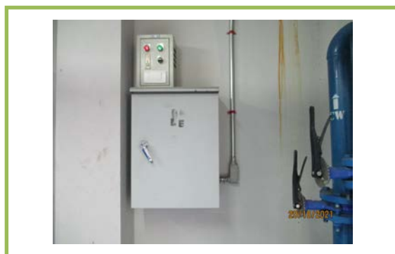
รูปที่ 13 ติดตั้งมิเตอร์ไฟฟ้าสำหรับระบบบำบัดน้ำเสีย
