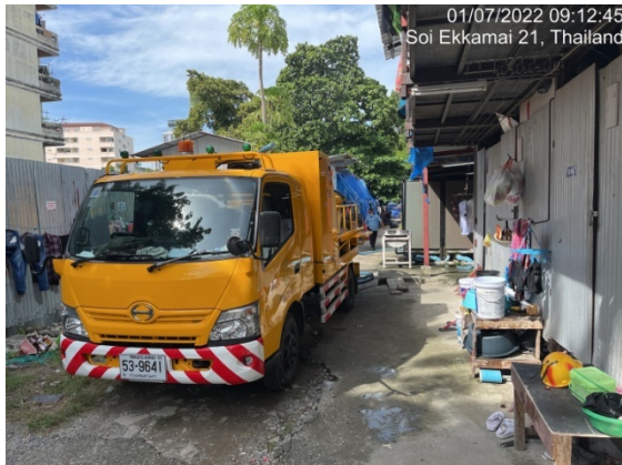
ภาพที่ 4-42 มีรถสูบล้างปลักุลเข้ามาสูบล้างจากระบบบำบัดน้ำเสียชั่วคราว
