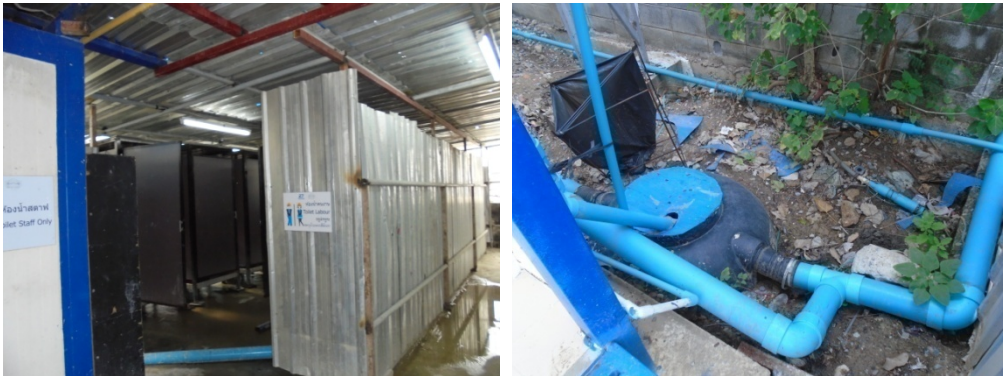
4-19 ห้องน้ำภายในพื้นที่ก่อสร้างและระบบบำบัดน้ำเสีย
