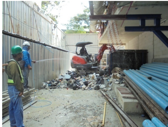
ภาพที่ 4-34 ชีตพรมน้ำกองเศษวัสดุก่อสร้างขณะขนถ่ายนำเก็บไว้เป็นส่วน
