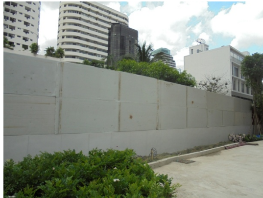
ภาพที่ 4-37 จัดทำรั้วทึบเป็นแผ่นกันเสียงบริเวณด้านทิศเหนือ เนื่องจากการร้องเรียนเสียงดังขณะตัดเสาเครน
