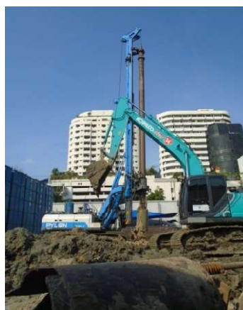
4-2 การทำเสาเข็มแบบเสาเข็มเจาะ
