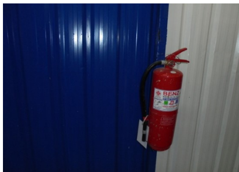
ภาพที่ 4-24 ติดตั้งถังเคมีดับเพลิงและวิธีการใช้ติดไว้ข้างถัง
