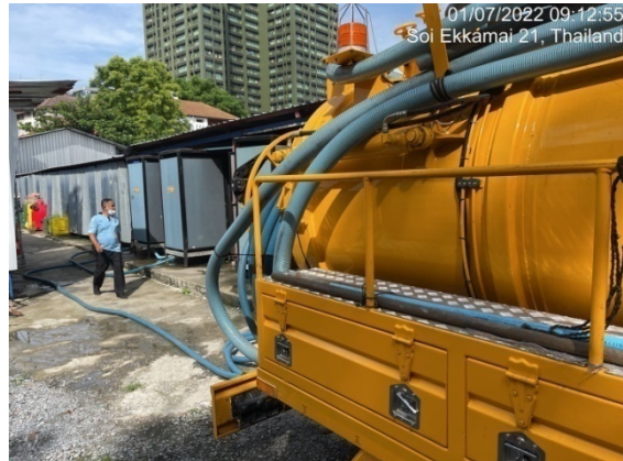
ภาพที่ 4-42 มีรถสูบล้างปลักุลเข้ามาสูบล้างจากระบบบำบัดน้ำเสียชั่วคราว
