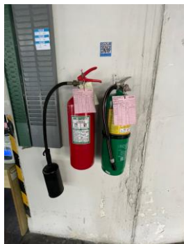
ถังดับเพลิง CO 2 และถัง ดับเพลิง Clean Agent
