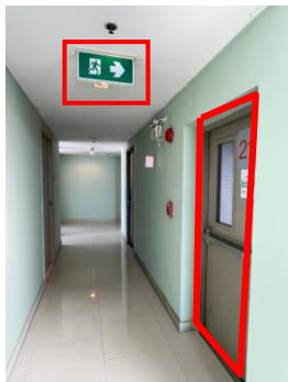
ป้ายไฟทางออกฉุกเฉิน และประตูหนีไฟ
