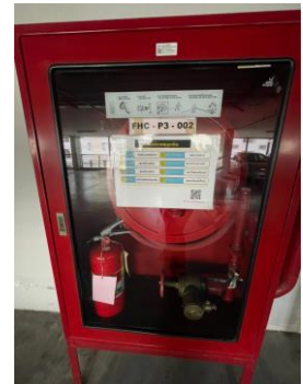
ตู้เก็บสายฉีดน้ำดับเพลิง พร้อมอุปกรณ์
