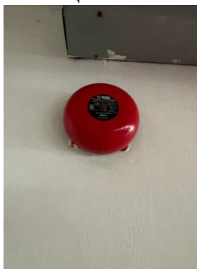
กริ่งเตือนเพลิงไหม้
