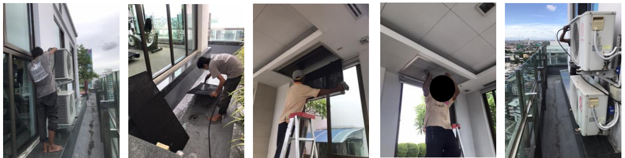
รูปที่ 2-22 ล้างเครื่องปรับอากาศส่วนกลาง
