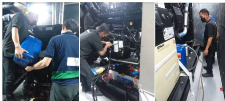
ภาพที่ 4-41 ตรวจสอบและรักษาระบบเครื่องสำรองไฟฟ้าฉุกเฉิน (Generator)
