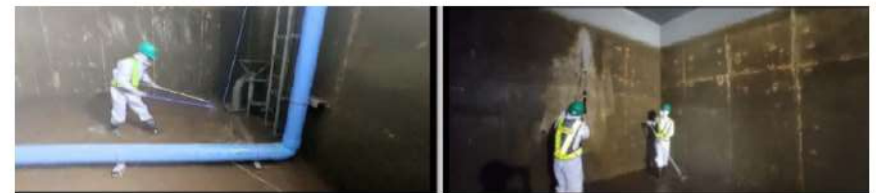
ล้างทำความสะอาดถังสำรองน้ำใช้ ที่โรงแรม คิมป์ตัน มาลัย
