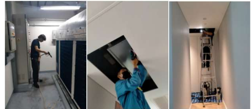
ทำความสะอาดระบบปรับอากาศที่อาคารบ้านลินธอร์
