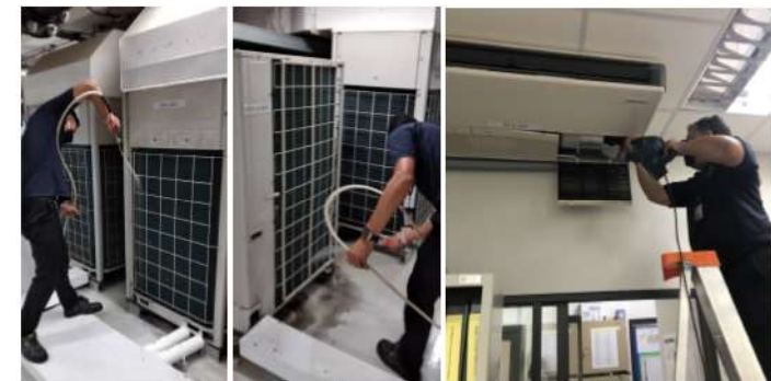
ทำความสะอาดระบบปรับอากาศที่เรสซิเดนซ์แอทลินธอร์เคมปินสกี
