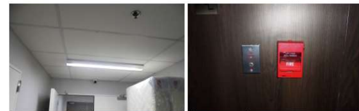
ภาพที่ 4-15 ระบบถังกระจายน้ำดับเพลิง เครื่องตรวจจับควัน เครื่องสูบลมเตือนภัย
