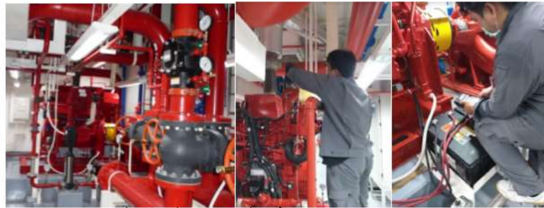
ภาพที่ 4-8 ห้องเครื่องปั๊ม และเครื่องสูบน้ำอัตโนมัติ และตรวจสอบดูแลรักษาระบบ
