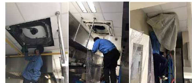
ทำความสะอาดระบบปรับอากาศที่โรงแรม ลินธอร์ เคมปินสกี
