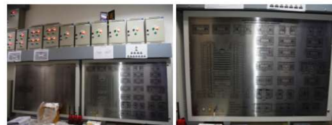
ภาพที่ 4-19 แผงควบคุมการรับส่งสัญญาณแจ้งเหตุเตือนอัคคีภัย
