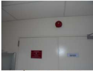
ภาพที่ 3-22 อุปกรณ์แจ้งเหตุโดยอัตโนมัติ
