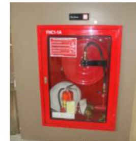
ภาพที่ 3-19 ตู้เก็บสายชนิดน้ำดับเพลิงและอุปกรณ์
