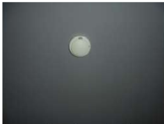
ภาพที่ 3-23 เครื่องตรวจจับความร้อน
