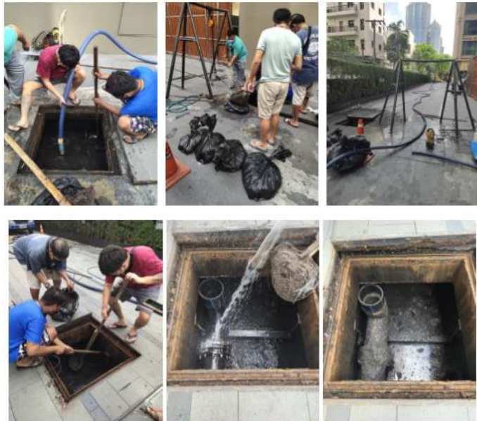
ภาพที่ 3-37 สืบตะกอนในระบบบำบัดน้ำเสีย
