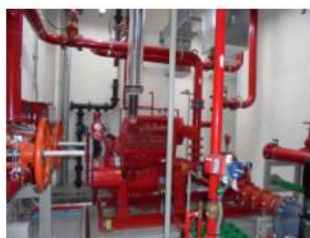
ภาพที่ 2-18 ห้องเครื่องดับเพลิง
