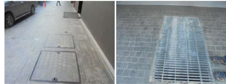
ภาพที่ 3-36 ระบบน้ำบ้น้ำเสียรวมของโครงการ และรางระบายน้ำ
