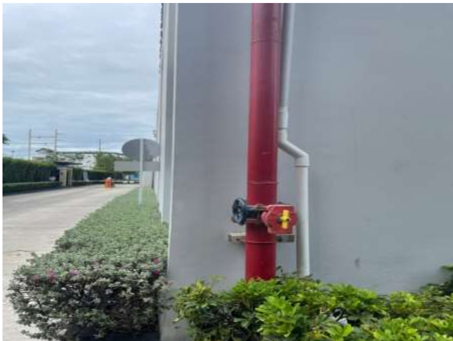
ภาพที่ 1.49 ภาพระบบท่อขึ้นดับเพลิง
