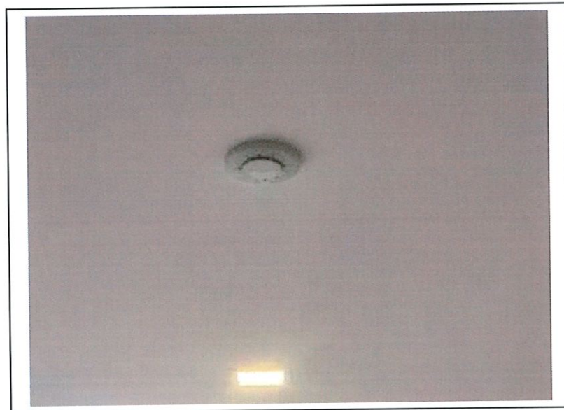
รูปที่ 24 เครื่องจับควัน
