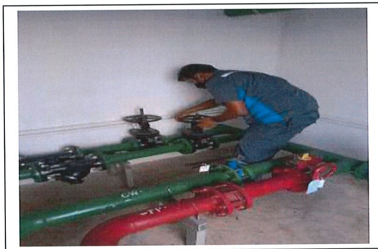
รูปที่ 29 ภาพช่างตรวจเช็คระบบปั้มน้ำ / สำรองน้ำ
