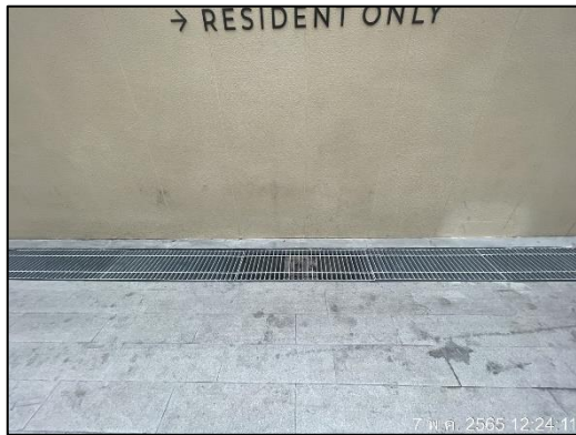
ภาพที่ 55 ตะแกรงครอบท่อระบายน้ำ
