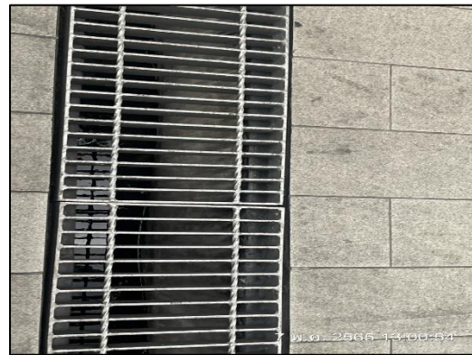
ภาพที่ 55 ตะแกรงครอบท่อระบายน้ำ
