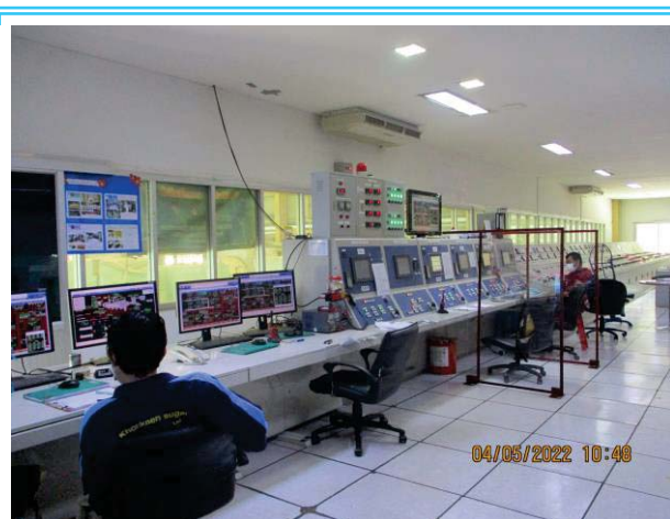
รูปที่ 3-73 ห้องควบคุมติดตั้งระบบ DCS ในการควบคุมการทำงานของหม้อไอน้ำ
