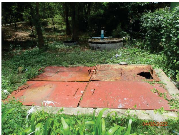
รูปที่ 3-26 ระบบถังแยกน้ำและน้ำมันบริเวณโรงอาหาร
