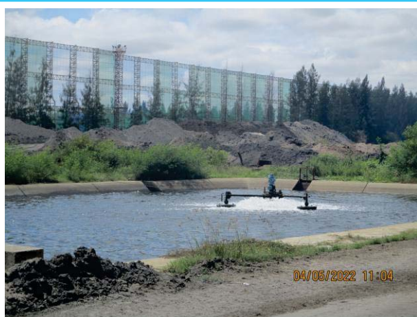
รูปที่ 3-31 ระบบบำบัดน้ำเสียแบบบ่อเติมอากาศ (Aerated Lagoon) ต่ออนุกรมกับบ่อบ่ม (Maturation Pond)
