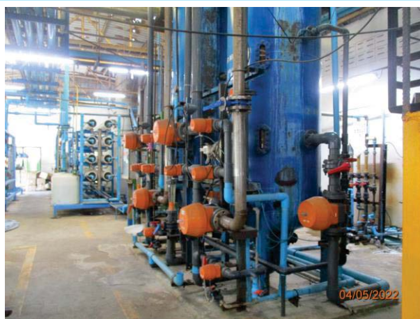
รูปที่ 3-30 ถังปรับสภาพน้ำจากการฟื้นฟูสภาพตัวกลาง
