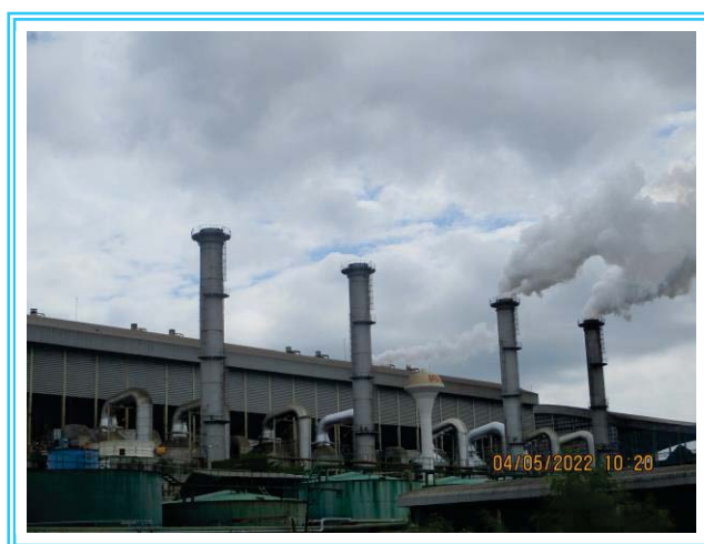
รูปที่ 3-2 ระบบดักฝุ่นแบบ Pre-dust Collector ต่ออนุกรมกับ Wet Scrubber สำหรับหม้อไอน้ำทั้ง 4 ชุด
