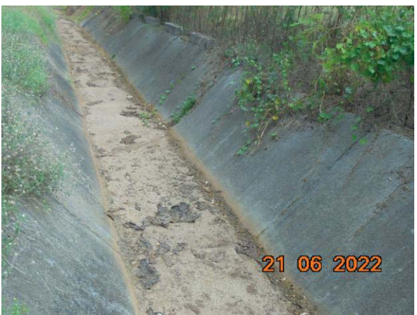
รูปที่ 3-28 รางระบายน้ำรอบลานกองเก็บกากอ้อย
