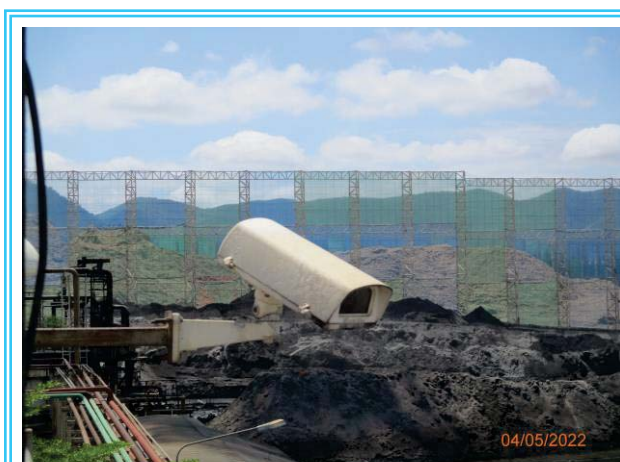
รูปที่ 3-74 กล้องวงจรปิดตรวจดูการระบายมลพิษทางอากาศจากปล่องหม้อไอน้ำ
