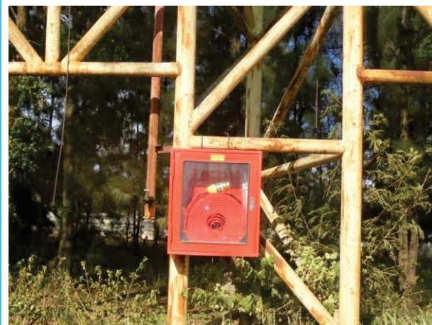
รูปที่ 3-59 ตู้เก็บสายส่งน้ำดับเพลิงบริเวณลานกองกากอ้อย
