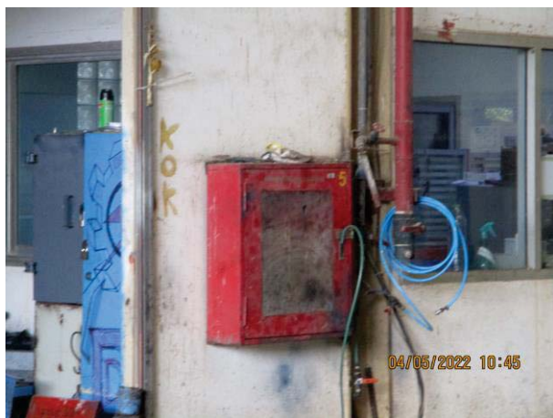
รูปที่ 3-58 ตู้เก็บสายส่งน้ำดับเพลิงบริเวณโครงการ
