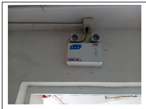
รูปที่ 2.14-5 ระบบไฟส่องสว่างสำรอง
