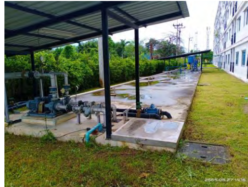
รูปที่ 3.1-18 ระบบสำรอนน้ำใช้ภายในโครงการ
