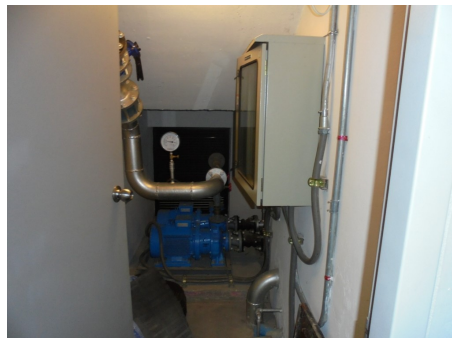
ภาพที่ 4-10 ถังเก็บน้ำใต้ดิน ฝาทังเก็บน้ำใต้ดิน และเครื่องสูบน้ำประปา
