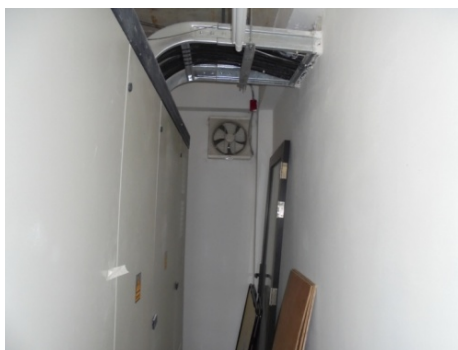
ภาพที่ 4-32 พัดลมระบายอากาศบริเวณห้องต่าง ๆ ที่ไม่มีช่องเปิดระบายอากาศ
