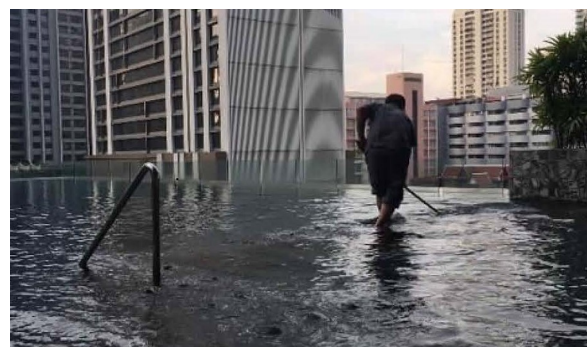
ภาพที่ 4-35 ล้างดูดตะกอนสระว่ายน้ำ
