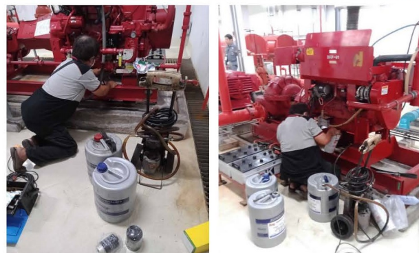
ภาพที่ 4-32 ตรวจสอบระบบไฟฟ้าและไฟฟ้าสำรอง และเครื่องสูบน้ำดับเพลิง
