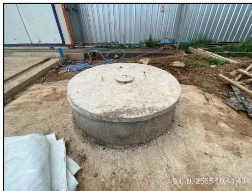
ภาพที่ 7 ปอดักตะกอนดินบริเวณทางเข้า-ออก
