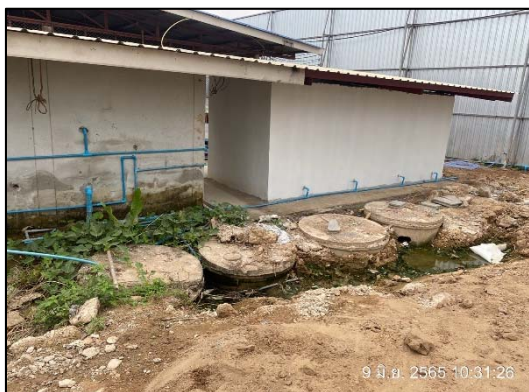
ภาพที่ 30 ระบบบำบัดน้ำเสียแบบซึมดิน
