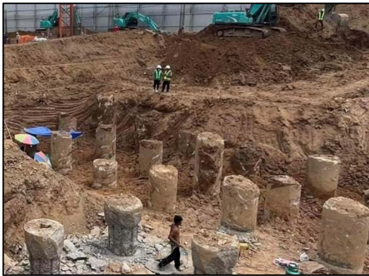
ภาพที่ 3 เสาเข็มดิน-ซีเมนต์ (Soil-Cement Column)
