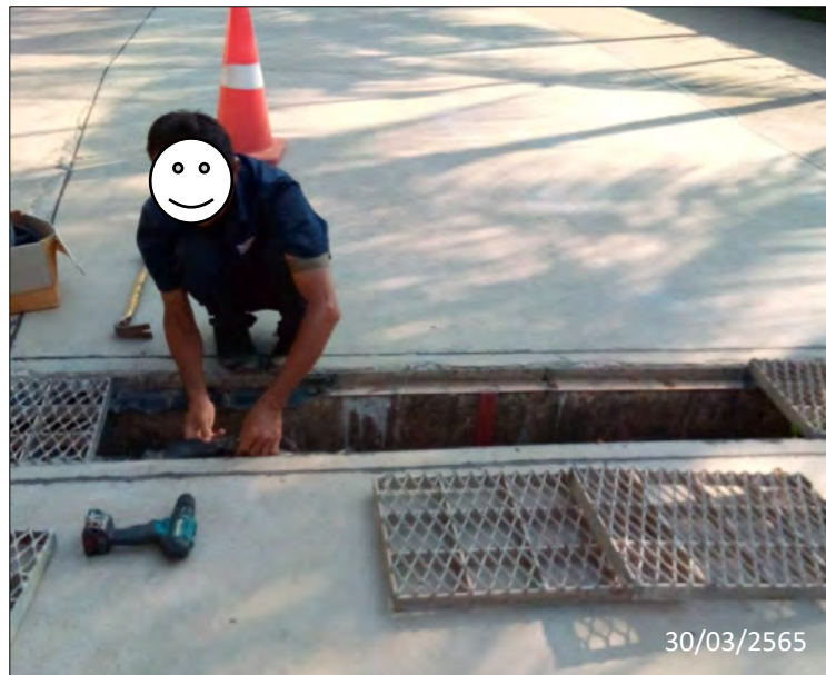
ภาพที่ 3-12 : เจ้าหน้าที่ทำความสะอาดและขุดลอกเศษตะกอนในท่อระบายน้ำและบ่อพักน้ำ
