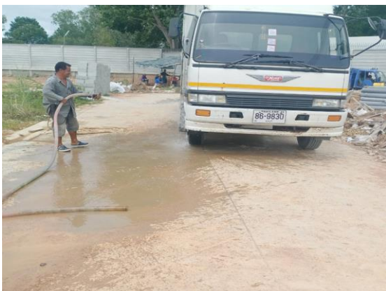
รูปที่ 3-9 พนักงานฉีดล้างล้อรถก่อนออกนอกพื้นที่โครงการ
