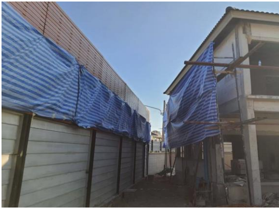
รูปที่ 3-7 ผ้าใบกันตั่วอาคาร (พื้นที่โครงการกับบ้านข้างเคียง)
