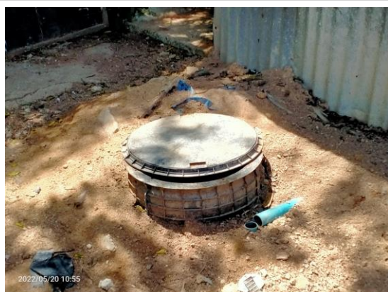
รูปที่ 3-17 ระบบบำบัดน้ำเสียชนิดเกราะ-กรองไร้อากาศ
