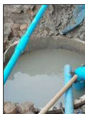
ภาพที่ 26 บ่อพักน้ำก่อนระบายออกสู่แหล่งน้ำสาธารณะ
