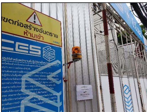
ภาพที่ 10 สัญญาณไฟเตือนกระพริบ
