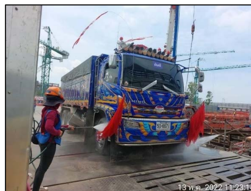
ภาพที่ 9 พื้นที่ล้างล้อ และกิจกรรมฉีดล้างล้อรถบรรทุก
