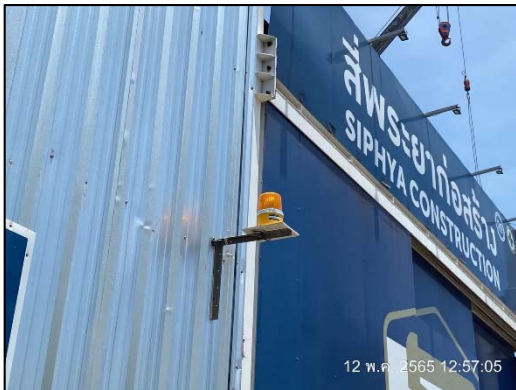
ภาพที่ 37 สัญญาณไฟกระพริบ
