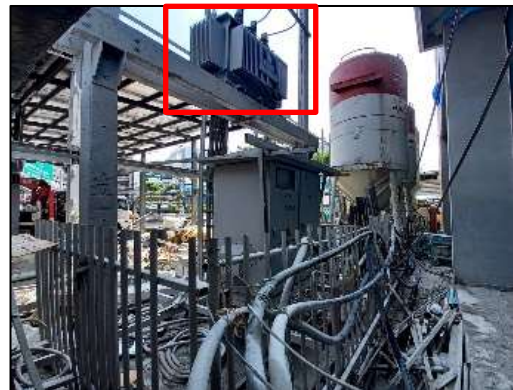
ภาพที่ 33 หม้อแปลงไฟฟ้า
