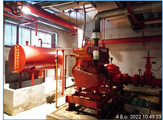
รูปที่ 2.31 ระบบ fire pump
