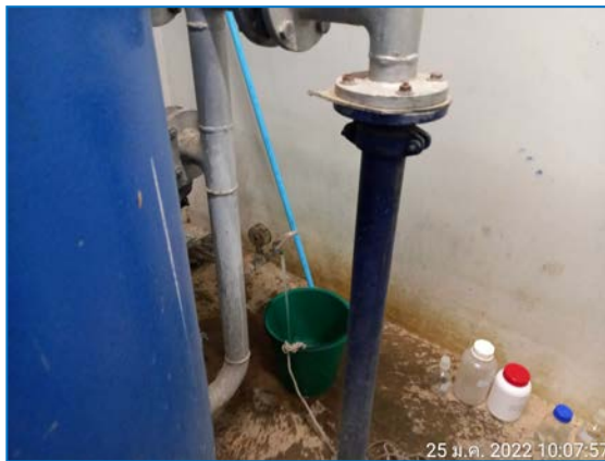
รูปที่ 3.1 แสดงการเก็บตัวอย่างน้ำผ่านการบำบัดน้ำเสียรวมของโครงการ
