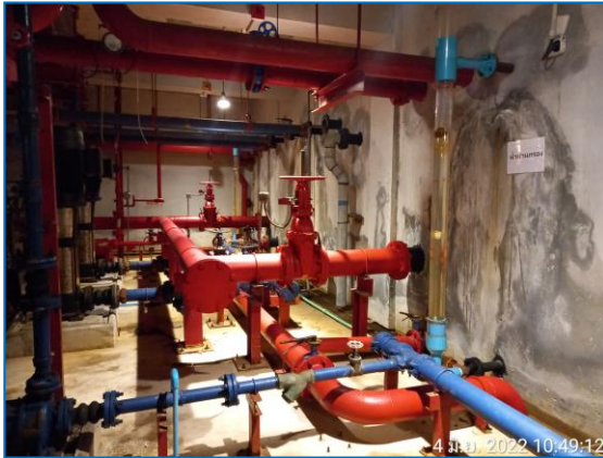
รูปที่ 2.31 ระบบ fire pump
