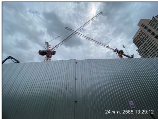
ภาพที่ 38 ควบคุมแขนของเครนให้อยู่ภายในพื้นที่โครงการ
