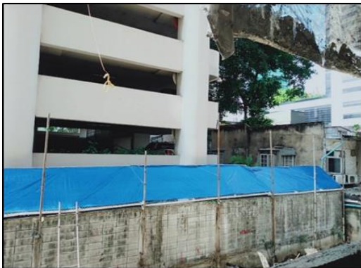
ภาพที่ 52 ติดตั้งแผ่นตาข่ายป้องกันวัสดุตกหล่นและราวกันตก
