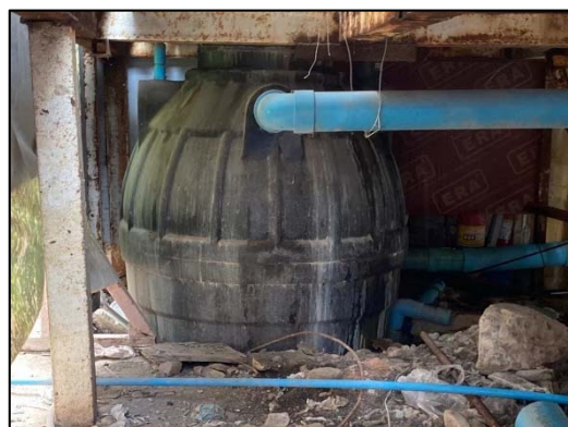
ภาพที่ 13 ถังบำบัดน้ำเสียสำเร็จรูป
