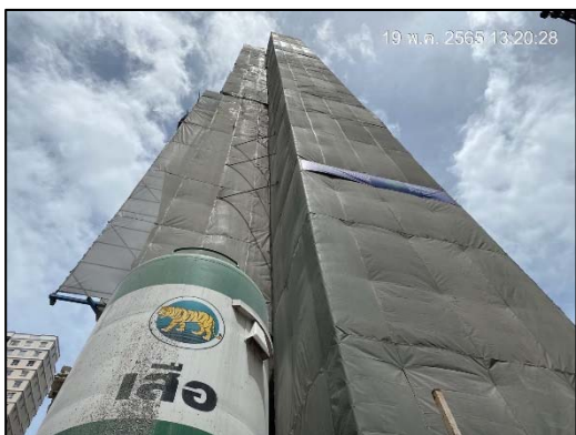
ภาพที่ 6 ผ้าใบก่อสร้าง (Mesh Sheet)
