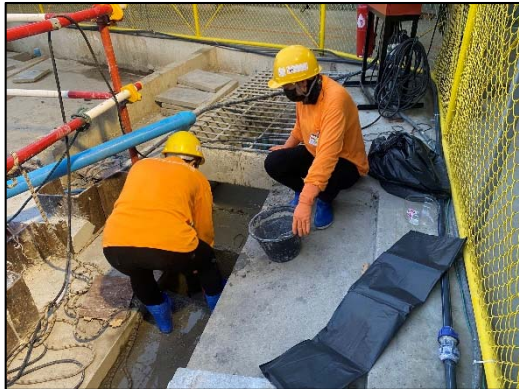
ภาพที่ 98 กิจกรรมขุดลอกตะกอนดิน
