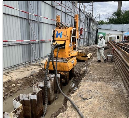
ภาพที่ 107 เครื่องกดซีตไพล์ระบบไฮดรอลิก (Silent Piler)
