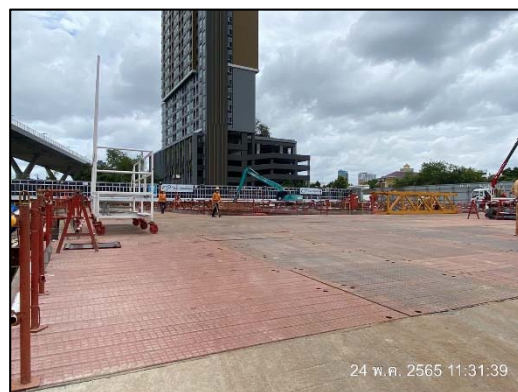
ภาพที่ 14 ปูแผ่นเหล็กบริเวณพื้นที่โครงการ
