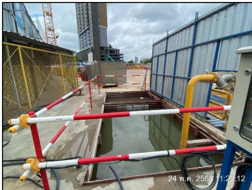
ภาพที่ 77 บ่อดักตะกอนดินจากการล้างล้อ
