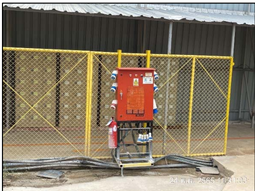
ภาพที่ 47 ตู้จ่ายไฟฟ้า
