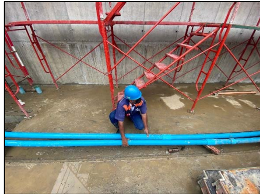
ภาพที่ 99 เจ้าหน้าที่ตรวจดูจุดรั่วซึมของท่อระบายน้ำ
