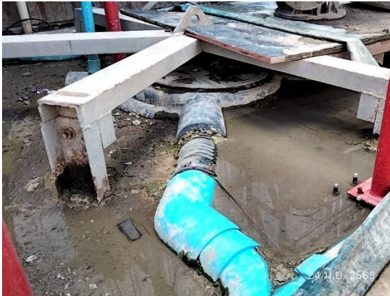
รูปที่ 2.47 บ่อพักน้ำเสียจากห้องน้ำ
