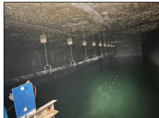
ภาพที่ 12 ถูกลอยสำหรับเปิด-ปิด รับน้ำประปา
