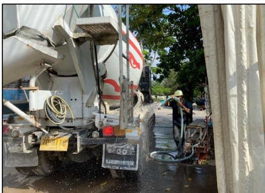
ภาพที่ 28 (ต่อ) พื้นที่สำหรับล้างล้อรถ และกิจกรรมล้างล้อรถก่อนออกจากโครงการ
