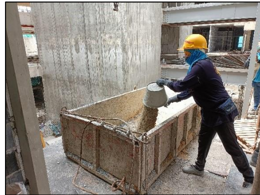
ภาพที่ 26 กระบะบรรจุทุกเศษวัสดุลงจากอาคาร
