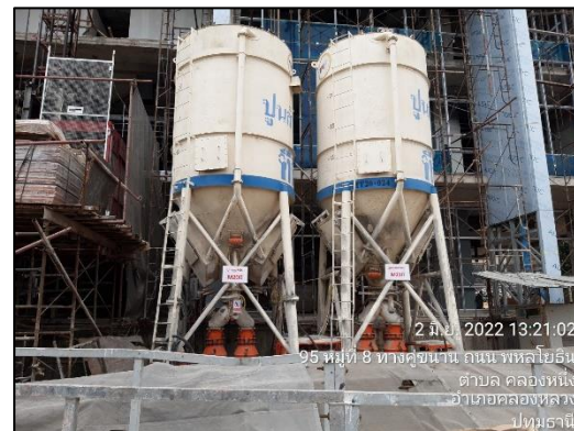
ภาพที่ 20 ปูนคอนกรีตสำเร็จรูป และพื้นที่เก็บปูนซีเมนต์ผง
