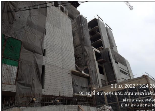
ภาพที่ 25 ผ้าใบกันฝุ่น (Mesh Sheet)
