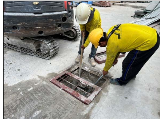
ภาพที่ 5 กิจกรรมขุดลอกตะกอนดิน
