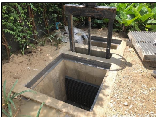
ภาพที่ 22 บ่อพักน้ำ และตะแกรงดักขยะ
