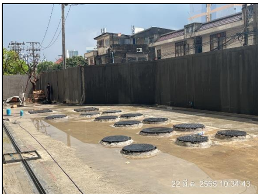
ภาพที่ 19 ระบบบำบัดน้ำเสียแบบถาวร
