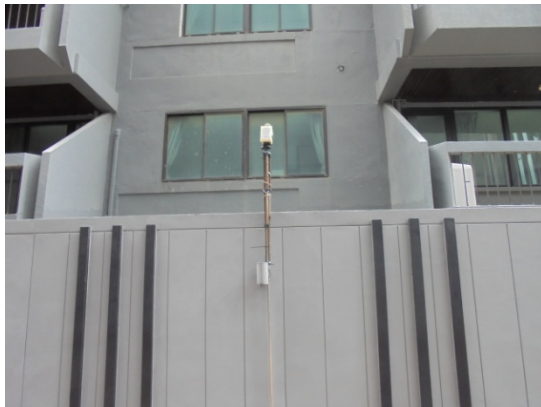
ภาพที่ 4-53 ปรับปรุงผนังอาคารจอดรถด้านทิศใต้ของอาคาร เป็นผนังกันเสียง ปิดทับป้องกันผลกระทบด้านเสียงจากอาคารจอดรถ ไปยังอาคาร ฟิสเจอ พาร์ทเมนท์ และอาคาร โรงแรม คราวน์ บีทีเอส นานา ติดตั้งเครื่องตรวจวัดเสียงบริเวณรั้วด้านทิศใต้ของอาคาร
