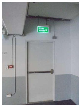
ภาพที่ 4-25 ประตุนิไฟ และป้ายทางออกฉุกเฉิน
