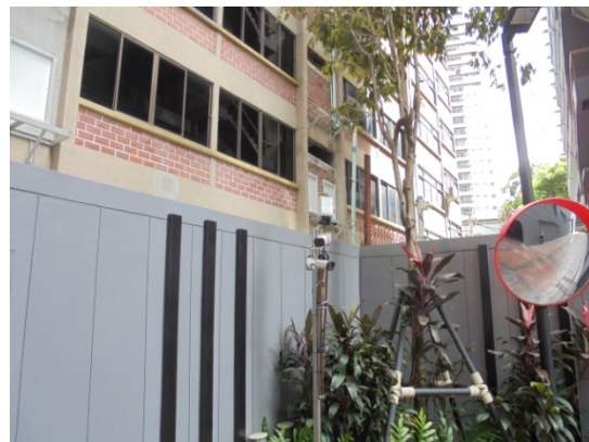
ภาพที่ 4-53 ปรับปรุงผนังอาคารจอดรถด้านทิศใต้ของอาคาร เป็นผนังกันเสียง ปิดทับป้องกันผลกระทบด้านเสียงจากอาคารจอดรถ ไปยังอาคาร ฟิสเจอ พาร์ทเมนท์ และอาคาร โรงแรม คราวน์ บีทีเอส นานา ติดตั้งเครื่องตรวจวัดเสียงบริเวณรั้วด้านทิศใต้ของอาคาร
