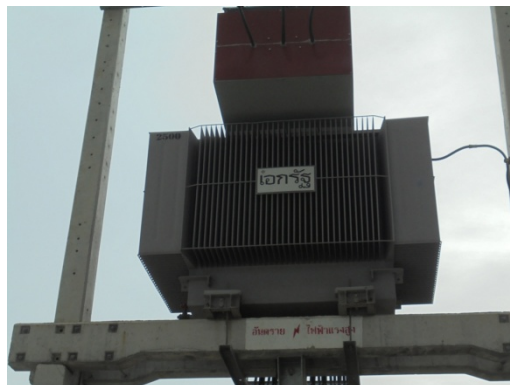
ภาพที่ 5-13 หม้อแปลงไฟฟ้า และป้ายบอกอันตราย
