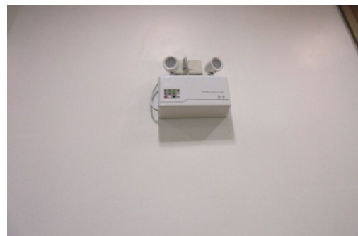
ภาพที่ 5-22 อุปกรณ์แจ้งเหตุโดยใช้มือดึง และกริ่งสัญญาณเตือนภัยและไฟฟ้าส่องสว่างฉุกเฉิน
