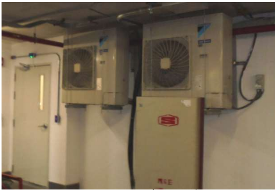
ภาพที่ 5-16 เครื่องปรับอากาศแบบ Split Type ใช้ภายในอาคาร
