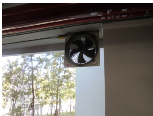
ภาพที่ 5-5 การระบายอากาศชั้นจอดรถ และพัดลมระบายอากาศ
