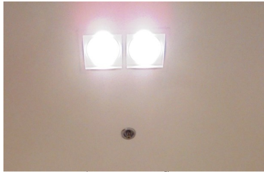
ภาพที่ 5-20 หัวกระจายน้ำดับเพลิง
