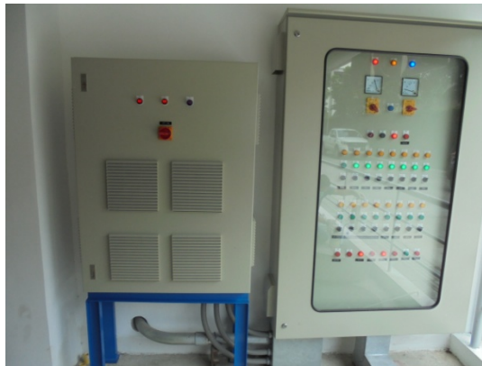
ภาพที่ 5-9 ตู้ควบคุมระบบบำบัดน้ำเสียและมิเตอร์แยกเฉพาะระบบบำบัดน้ำเสีย
