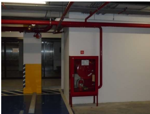
ภาพที่ 5-18 ท่อย่นระบบน้ำดับเพลิง และตู้เก็บสายฉีดน้ำดับเพลิงพร้อมอุปกรณ์
