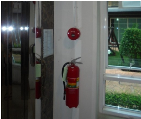
ภาพที่ 6-31 ถังเคมีดับเพลิงติดวิธีการใช้ไว้ข้างถัง
