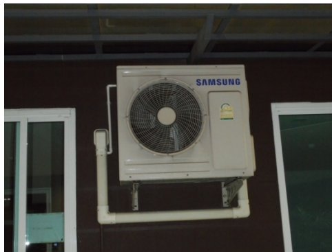
ภาพที่ 6-7 เครื่องปรับอากาศใช้แบบมีฉลากประหยัดไฟเบอร์ 5
