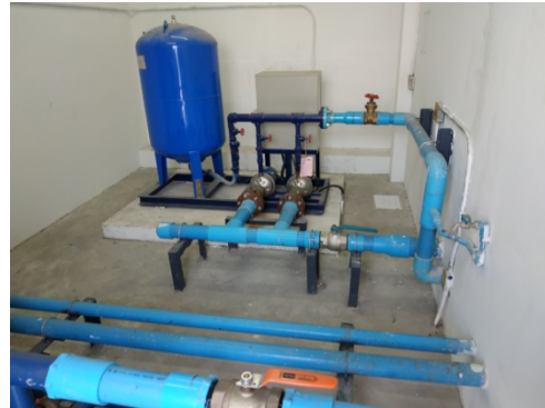
ภาพที่ 6-12 ถังเก็บน้ำชั้นดาดฟ้าและปั๊มสูบน้ำ
