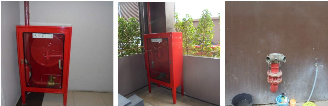
ภาพที่ 6-34 อุปกรณ์ดับเพลิง ตู้เก็บสายฉีดน้ำดับเพลิงพร้อมอุปกรณ์ หัวรับน้ำดับเพลิงจากภายนอก
