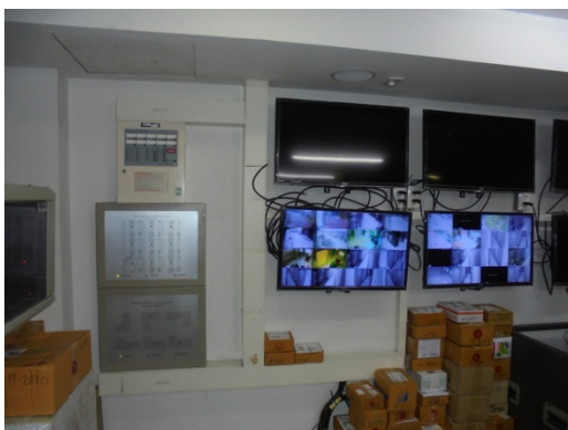
ภาพที่ 6-39 แผงควบคุมสัญญาณเตือนอัคคีภัย และระบบโทรทัศน์วงจรปิดของอาคาร
