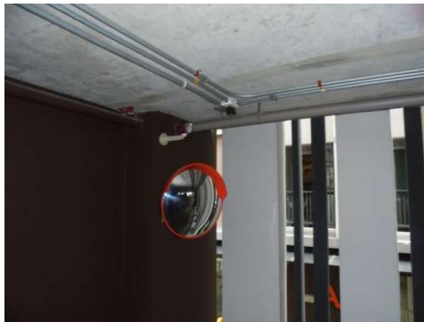
ภาพที่ 6-23 กระจกนูนโค้ง ติดตั้งบริเวณจุดอับสายตา และกล้องวงจรปิด
