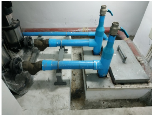
ภาพที่ 6-11 ถังเก็บน้ำใต้ดินและปั๊มสูบน้ำ
