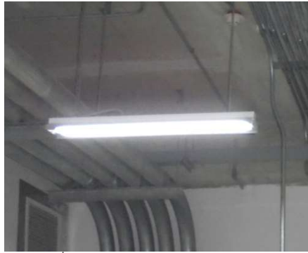
ภาพที่ 3-9 ตัวอย่างหลอดไฟส่องสว่างภายในโครงการใช้หลอดฟลูออเรสเซนต์ที่เป็นหลอดผอมทั้งหมด
