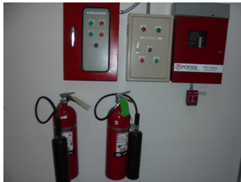
ถังดับเพลิงเคมีและระบบหัวกระจายน้ำดับเพลิงภายในห้องไฟฟ้า MDB
