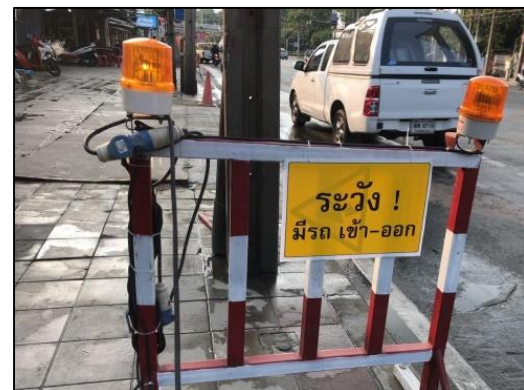
ภาพที่ 38 สัญญาณไฟกระพริบ และป้ายบอกทางเข้า-ออกโครงการ
