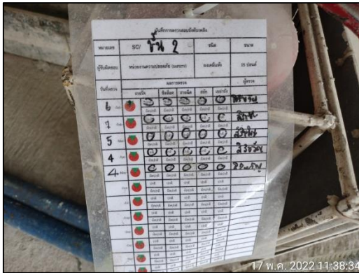
ภาพที่ 35 ตรวจสอบเช็คสภาพถังดับเพลิง
