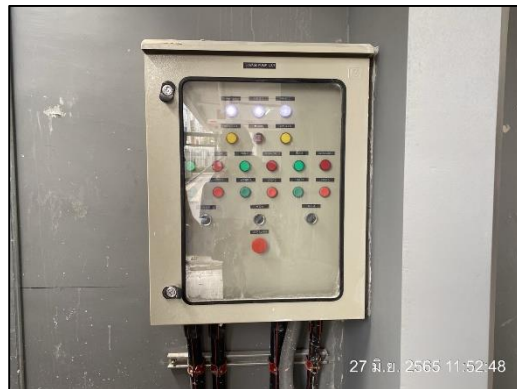
ภาพที่ 12 เครื่องควบคุมสูบน้ำ
