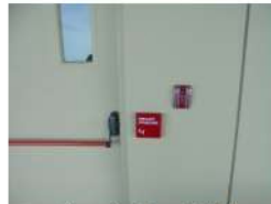
ภาพที่ 3-27 อุปกรณ์แจ้งเหตุเพลิงไหม้ในห้อง
