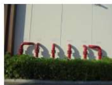
ภาพที่ 3-23 ตู้ขึ้นน้ำดับเพลิงจากภายนอกของโครงการ
