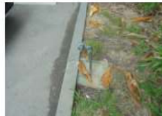
ภาพที่ 3-6 ที่เก็บน้ำเสียที่สร้างขึ้นจากท่อพลาสติก
