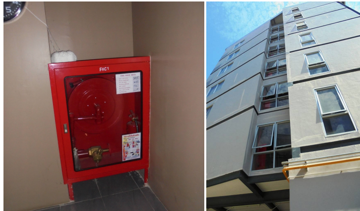
ภาพที่ 4-15 ระบบท่อเย็นและตู้เก็บสายฉีดน้ำดับเพลิงพร้อมอุปกรณ์
