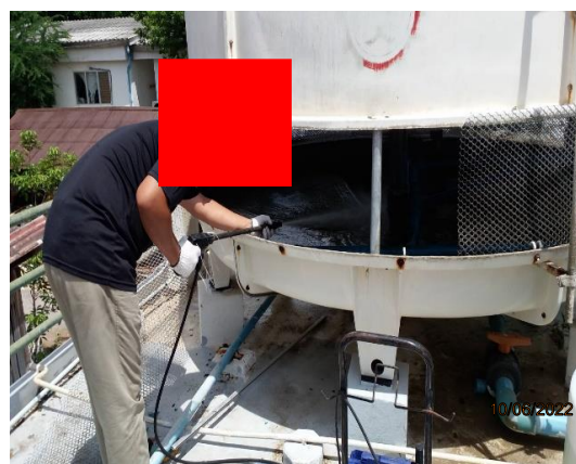
รูปที่ 2-34 การตรวจสอบ บำรุงรักษา ระบบหอผึ่งน้ำ (Cooling Tower)
