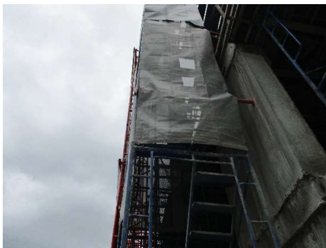
รูปที่ 6 Mesh Sheet คลุมโดยรอบอาคาร
