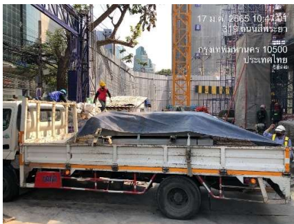
รูปที่ 36 รถบรรทุกติดแผ่นป้ายสะท้อนแสง/รถบรรทุกคลุมท้ายด้วยผ้าใบ
