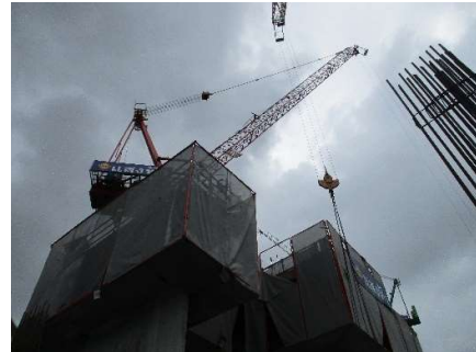
รูปที่ 40 การควบคุมการกวาดแขนของเครน ให้อยู่ภายในพื้นที่ก่อสร้าง ไม่ล้ำไปยังพื้นที่ข้างเคียง
