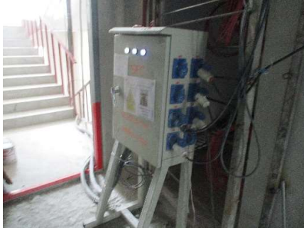
รูปที่ 27 ตู้ควบคุมไฟฟ้าและป้ายชื่อพร้อมเบอร์โทรช่างไฟฟ้าประจำโครงการ
