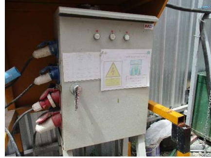
รูปที่ 27 ตู้ควบคุมไฟฟ้าและป้ายชื่อพร้อมเบอร์โทรช่างไฟฟ้าประจำโครงการ
