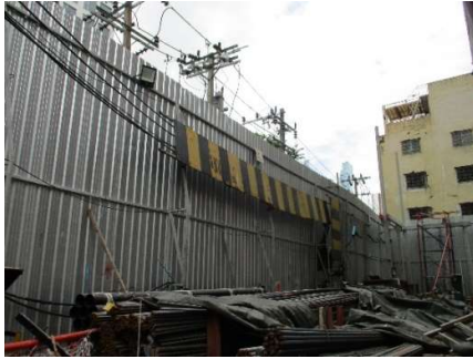
รูปที่ 1 รั้ว Metal Sheet สูง 6 เมตร ล้อมรอบพื้นที่โครงการ
