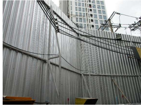
รูปที่ 1 รั้ว Metal Sheet สูง 6 เมตร ล้อมรอบพื้นที่โครงการ
