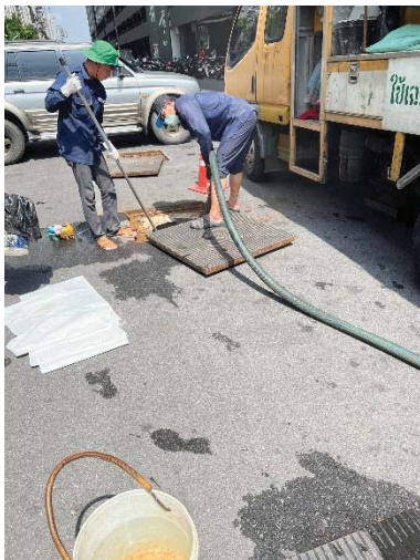
เจ้าหน้าที่ทำการตรวจสอบระบบบำบัดน้ำเสีย
