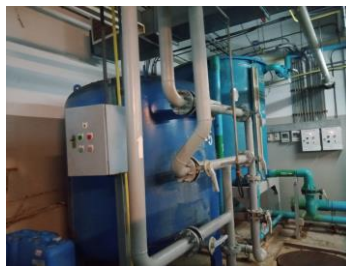
ระบบนำน้ำหลังบำบัดกลับมาใช้ใหม่ และจุดใช้น้ำหลังบำบัดรดต้นไม้
