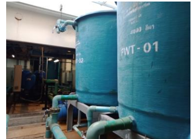
ระบบนำน้ำหลังบำบัดกลับมาใช้ใหม่ และจุดใช้น้ำหลังบำบัดรดต้นไม้
