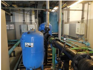
ระบบนำน้ำหลังบำบัดกลับมาใช้ใหม่ และจุดใช้น้ำหลังบำบัดรดต้นไม้
