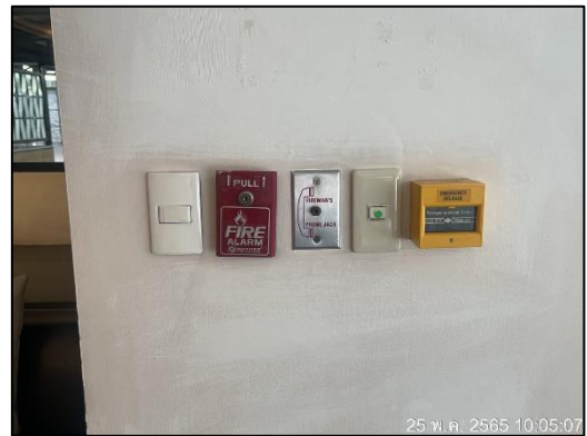
ภาพที่ 12 กริ่งสัญญาณเตือนภัย (Fire Alarm)
