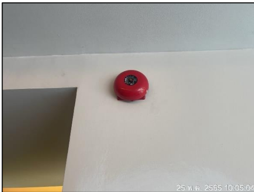
ภาพที่ 12 กริ่งสัญญาณเตือนภัย (Fire Alarm)
