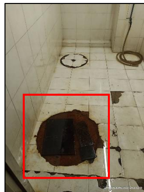
ภาพที่ 33 ท่อรวบรวมน้ำน้ำเสียห้องพักมูลฝอย
